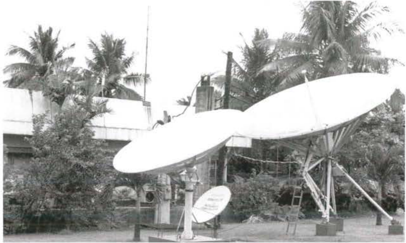
Ningún sistema sencillo de observación ha tenido consecuencias tan grandes sobre el SMO como los satélites meteorológicos: receptores de satélite meteorológico en Filipinas (Fotografía: PIAS)
