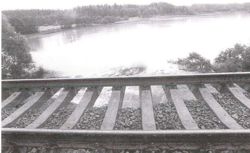
Respuesta de un Miembro a la solicitud anual de la Secretaría General de información sobre los impactos socioeconómicos de los fenómenos meteorológicos: daños en la infraestructura de transporte causados por lluvias fuertes en Letonia en 1998 (foto: Ulda Brieva)
