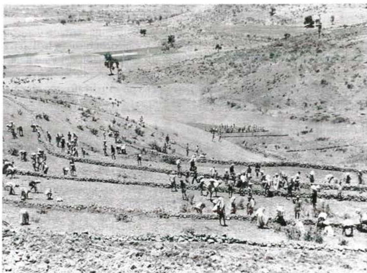
Los lugareños de las regiones montañosas de Etiopía colaboran en los trabajos de construcción de bancales. Este proyecto forma parte del programa de las Naciones Unidas de alimentos para el trabajo.
