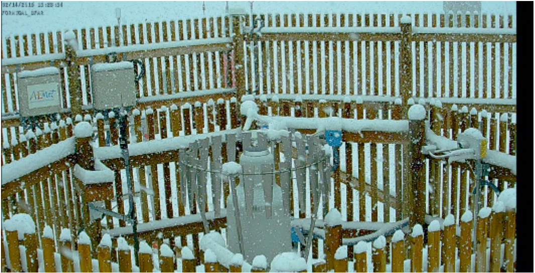
Figura 7. Interior del DFAR con OTT Pluvio 2 de pesada y disdrómetro tipo LPM de Thies.
