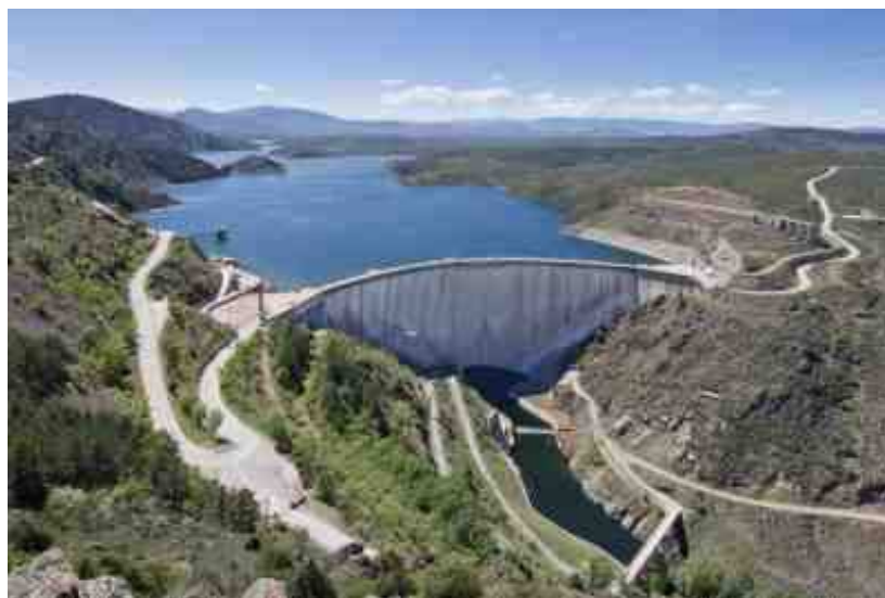
Presa de «El Atazar», Madrid (Foto Carlos Delgado, Wikipedia)
