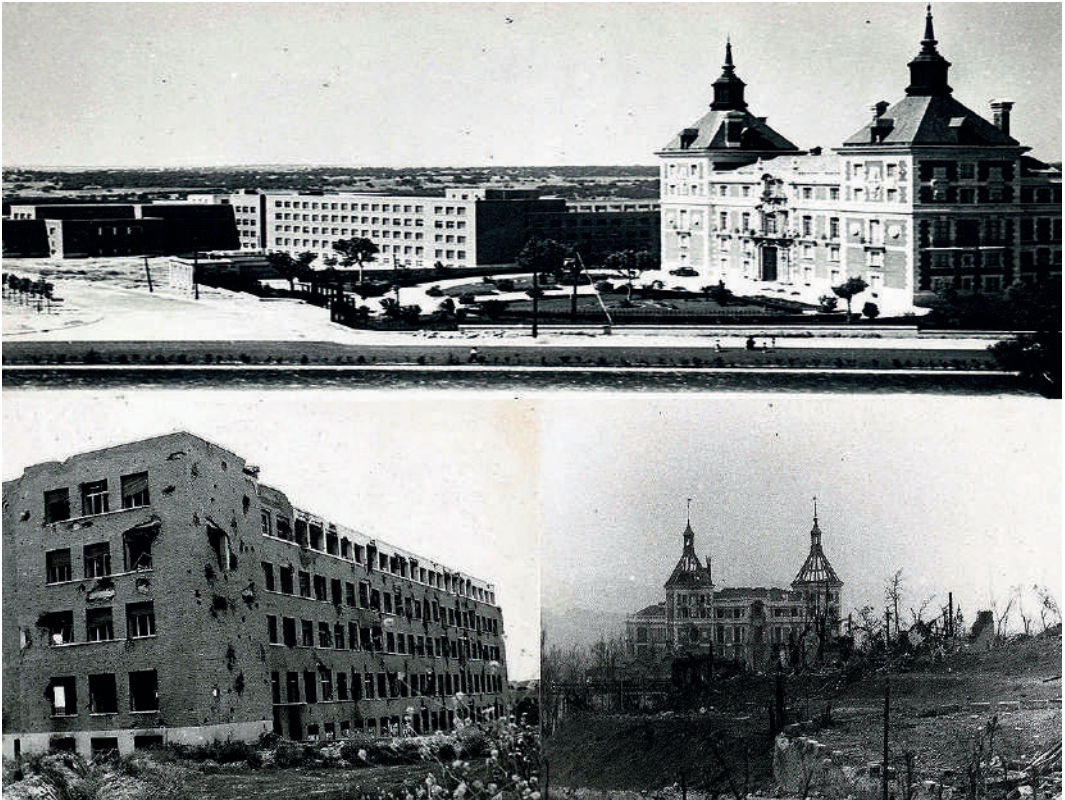
Imágenes de algunos de los edificios destruidos en el frente de batalla. Escuela de Arquitectura y Casa de Velázquez, antes y después. (Fuente: Biblioteca Digital Hispánica, Biblioteca Nacional de España).
