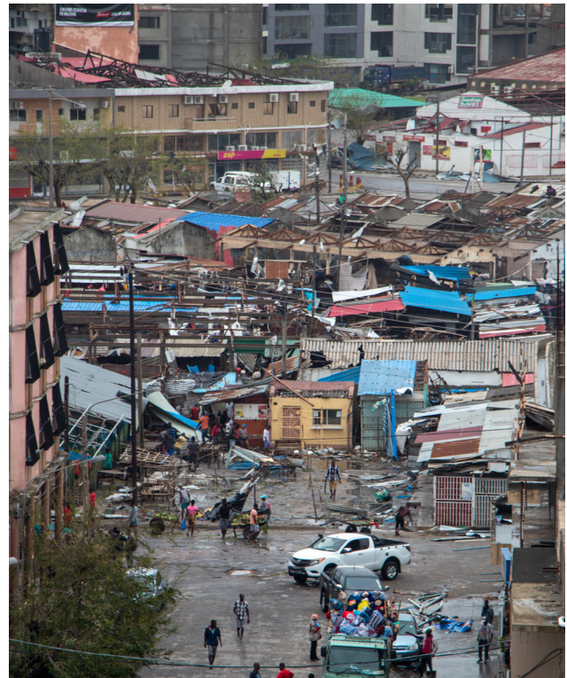
Figura 4. Después del paso del fuerte ciclón Idai, el rastro de destrucción que dejó en la ciudad de Beira era muy visible. El ciclón arrancó los techos, ¡nada era igual! (Fuente: iStock/Duarte Gouveia).
