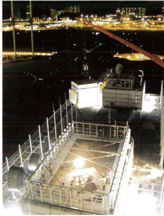
Figura 4 — Traslado del LIDAR a la azotea del Complejo del Control de Tránsito Aéreo, en el HKIA
