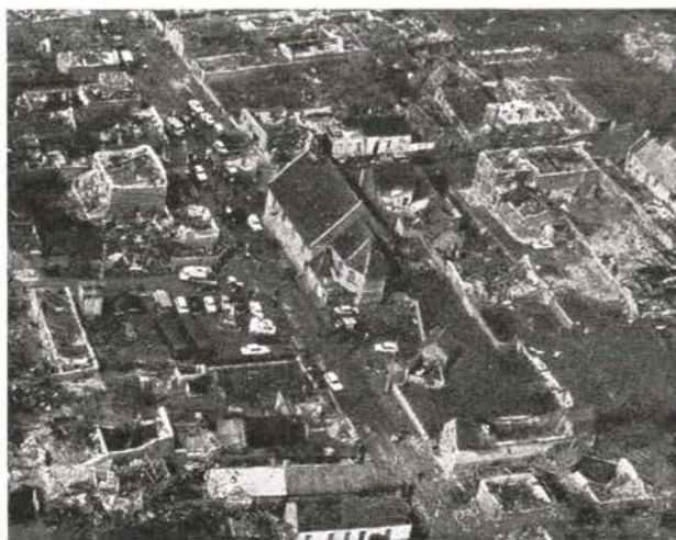
Francia: El tornado de 24 de junio de 1967 destruyó el 95 por 100 de los edificios de la ciudad de Pommereuil. (Foto: La Voix du Nord, Lille.)
