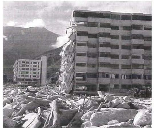
Figura 4 — Daños por flujo de detritos en dos edificios del cono aluvial del río San Julián (la foto de abajo es una vista más cercana del edificio del fondo de la figura de arriba).
