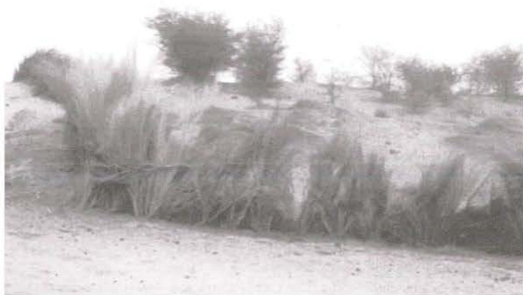
Defensas levantadas para impedir el avance de las dunas de arena (Foto: FAO)
