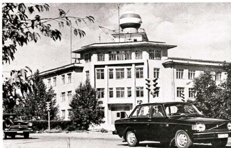
Figura 1.—El edificio de la Dirección Central del Servicio Hidrometeorológico de Mongolia.
