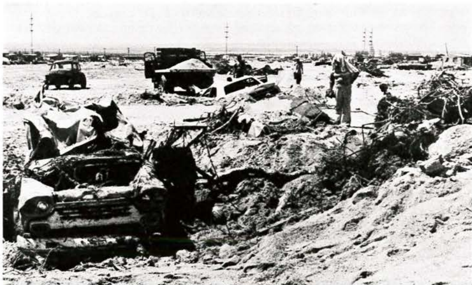
Figura 2 — Daños en La Paz, Baja California, México, causados por el huracán Liza que azotó la zona entre el 1 y el 3 de octubre de 1976, con 652 muertos y 80.000 heridos. Se estimaron pérdidas por valor de 300 millones de pesos
