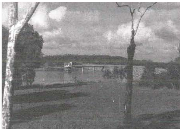
Presa y estructura de la entrada
