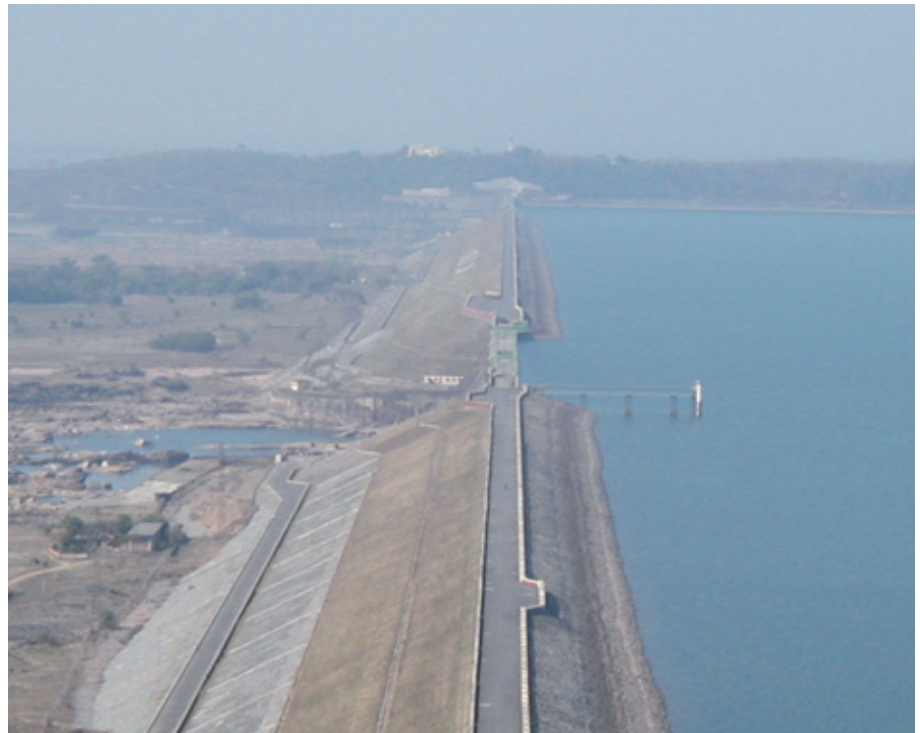
Presa de Hirakud
