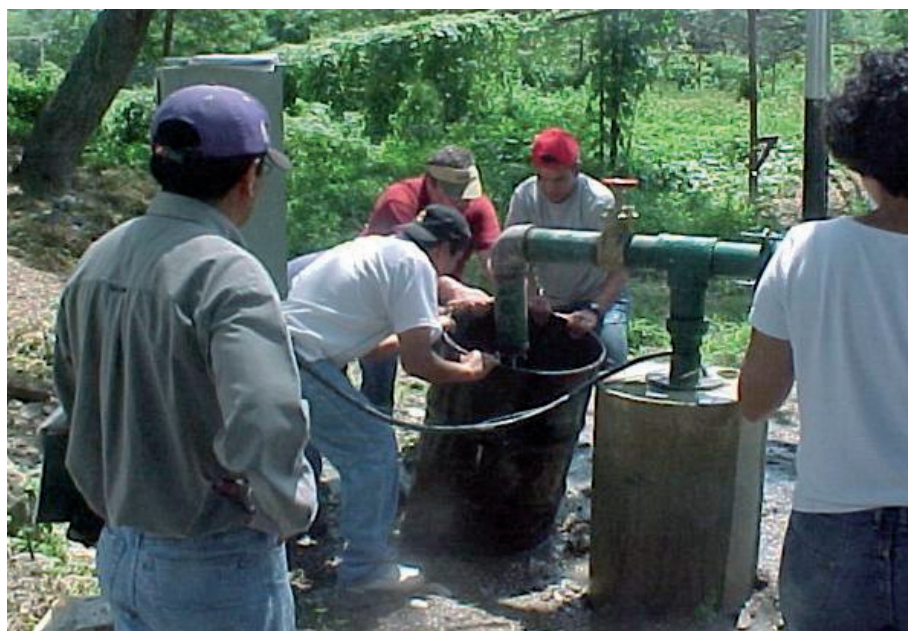
Estudiantes realizando un ensayo de bombeo durante un viaje de campo
