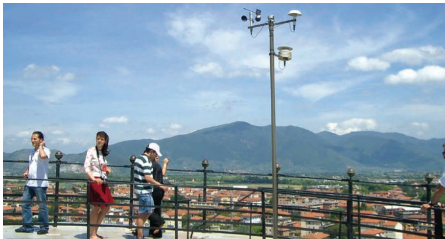
Estación meteorológica automática instalada en la terraza superior de la Torre de Pisa (Italia)
