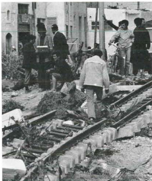
Túnez— En Sfax, en octubre de 1982, tramo de vía férrea arrastrado por las aguas desbordadas. (Fotografía: Dar Essabah/Karray Slim)
