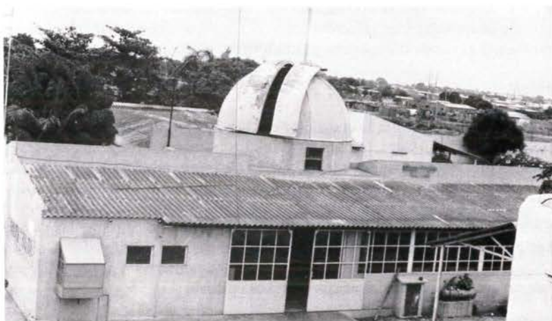
Vista del taller de reparación de equipos electrónicos en el Centro Regional de Formación Profesional en Meteorología de Mulemba.
