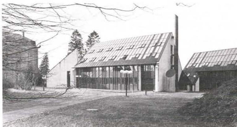
En los edificios de la Fondation universitaire luxembourgeoise , una batería de paneles solares está conectada a un sistema experimental subterráneo de almacenamiento de energía.
