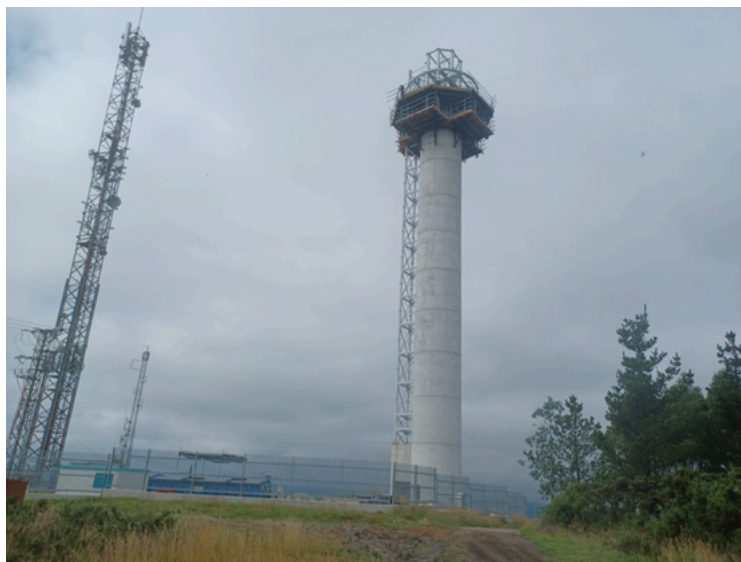
Estado actual de las obras del radar de A Coruña
