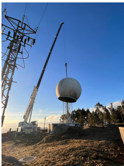
Inicio de las obras del radar de A Coruña
