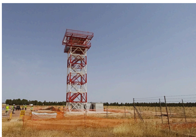
Estado actual del radar de Ciudad Real en la base aérea de Defensa de Almagro. Los colores rojo y blanco son obligados en instalaciones aeroportuarias
