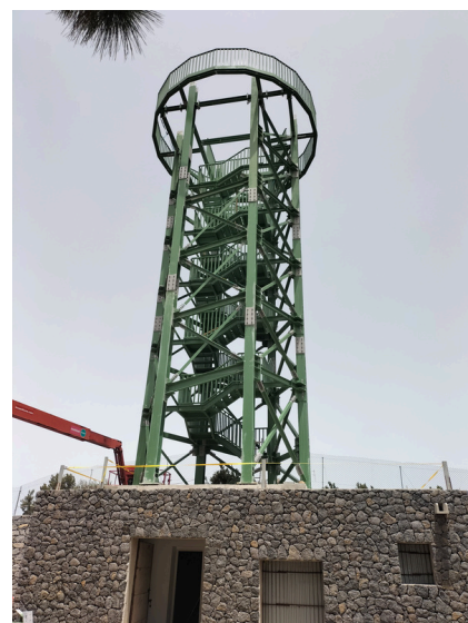
Estado actual de las obras del radar de Tenerife. El color verde de su estructura se adecúa al espacio natural protegido.
