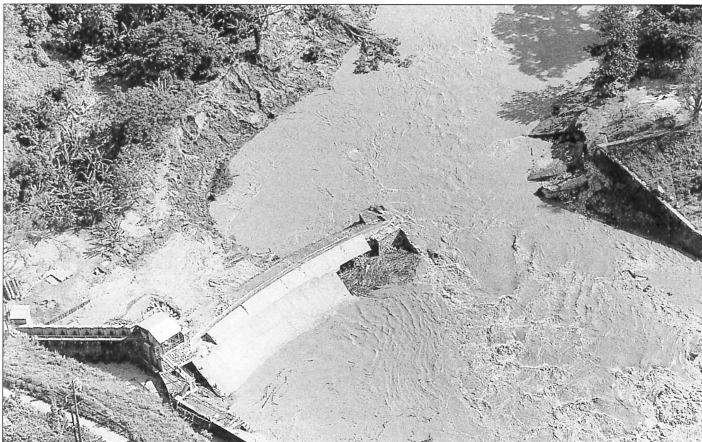
Jamaica, mayo de 1991 — Rotura de una presa sobre el río Cobre a consecuencia de las inundaciones causadas por las lluvias. Fotografía: J. S. Tyndale Biscoe
