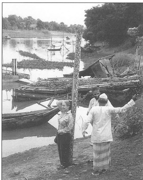
El extremo superior de este poste de medida del caudal, en la estación Pubail del río Banar, en Bangladesh, ha sido cubierto por las riadas muchas veces
