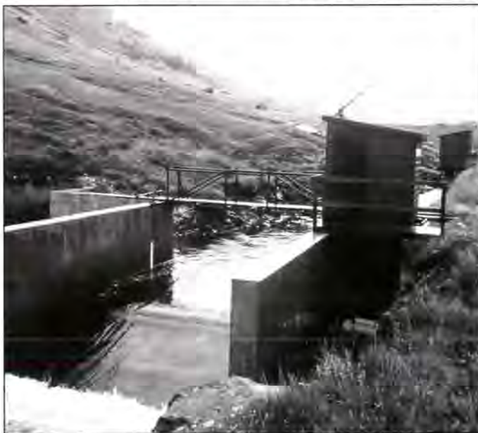
DCP de aforos fluviales en las tierras altas de Escocia, Reino Unido
