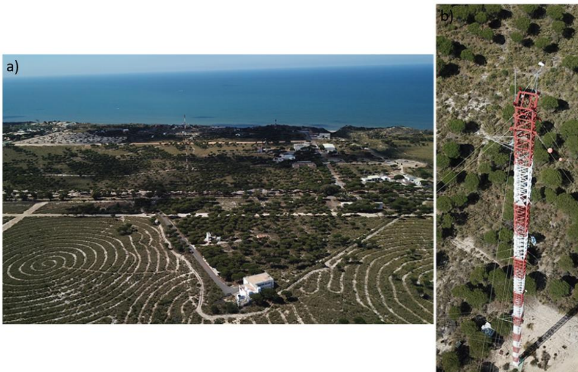
Figura 13. a) Imagen aérea de la estación atmosférica de El Arenosillo, en la que se observan el observatorio, la torre de 100 m y el océano Atlántico al fondo. b) Vista superior de la torre de 100 m.
