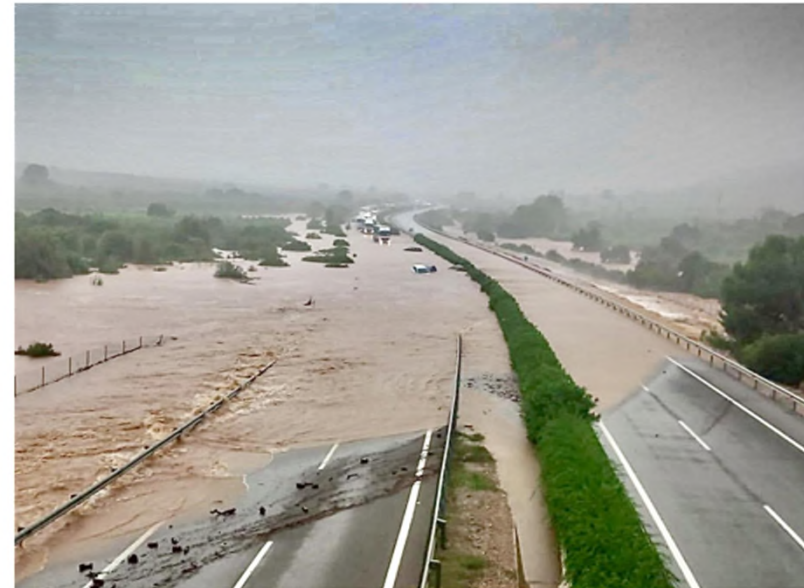
El agua cortó carreteras, la autopista AP-7, entre Uldecona y Freginals (en la imagen), y las líneas férreas (Roger Heredia/Projecte4estacions)
