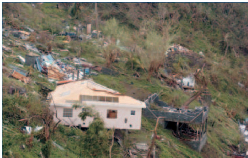
El huracán Iván destruyó, en septiembre de 2004, el 90 por ciento de los edificios de Granada.
