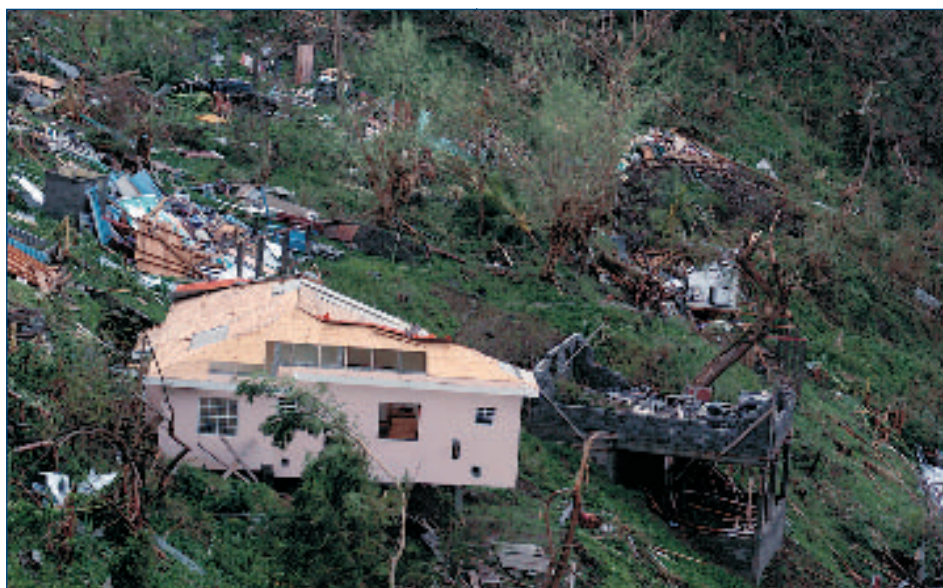
Daños causados por un huracán en Granada: más del 90 por ciento de las construcciones de la isla resultaron destruidas.
