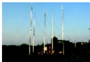
Sistema de localización de tormentas
