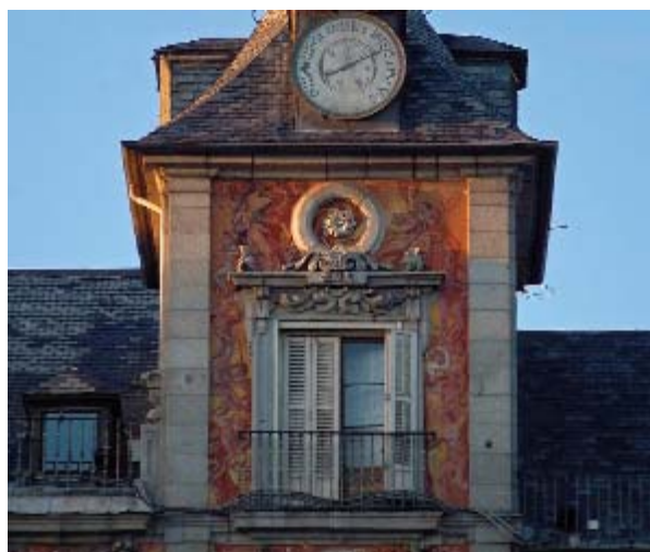
Detalle de la torre derecha de la Casa de la Panadería, en la Plaza Mayor de Madrid, con el barómetro aneroide referido en el texto.
