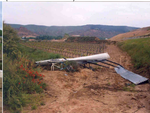
Foto 7: La estructura del techo de la casilla y una bicicleta que había en su interior, depositados a 120 m. de la misma.
